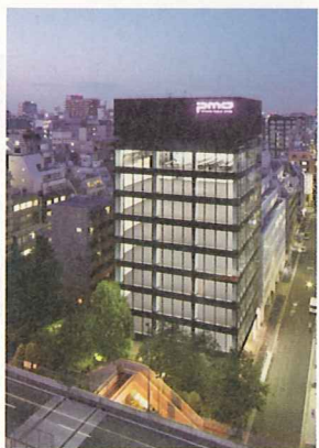
PMO日本橋本町
