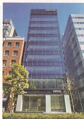
PMO東日本橋
